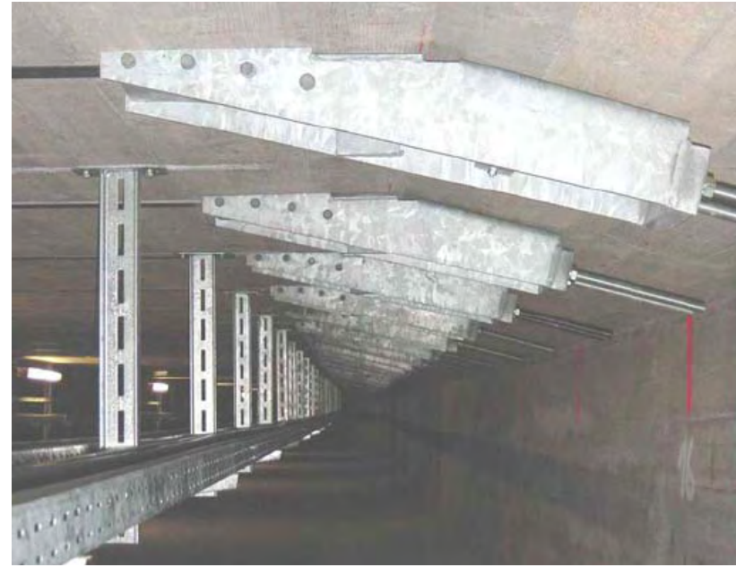
Glarus, Svizzera Applicazione di Sika® CarboStress®
