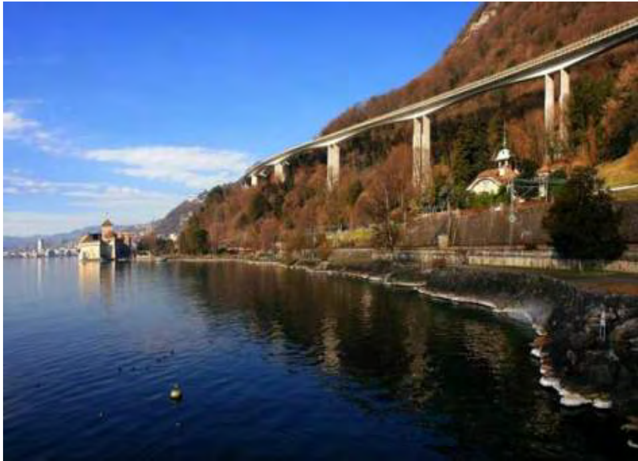
Viadotto di Chillon, Svizzera. Primo utilizzo di adesivi strutturali.
