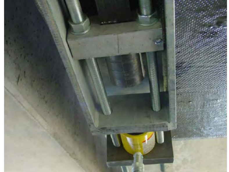
Clinton & Opkins bridge, Ohio (USA) Applicazione di Sika® CarboStress®
