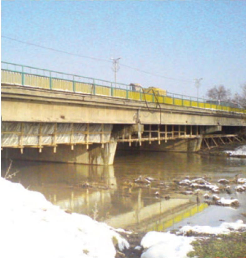
Ponte Sulzliyka in Bulgaria: applicazione di Sika CarboDur® a basse temperature
