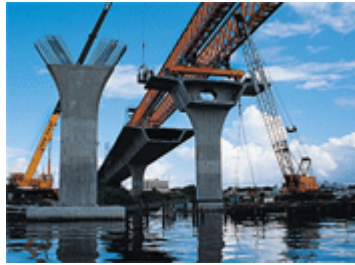
Produzione del calcestruzzo
