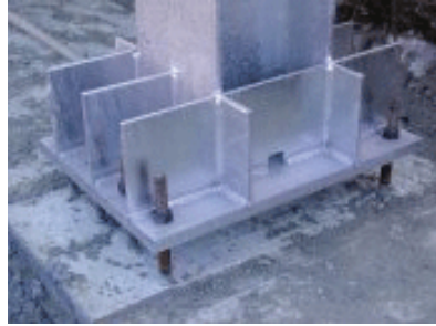
Riempimento e fissaggio
