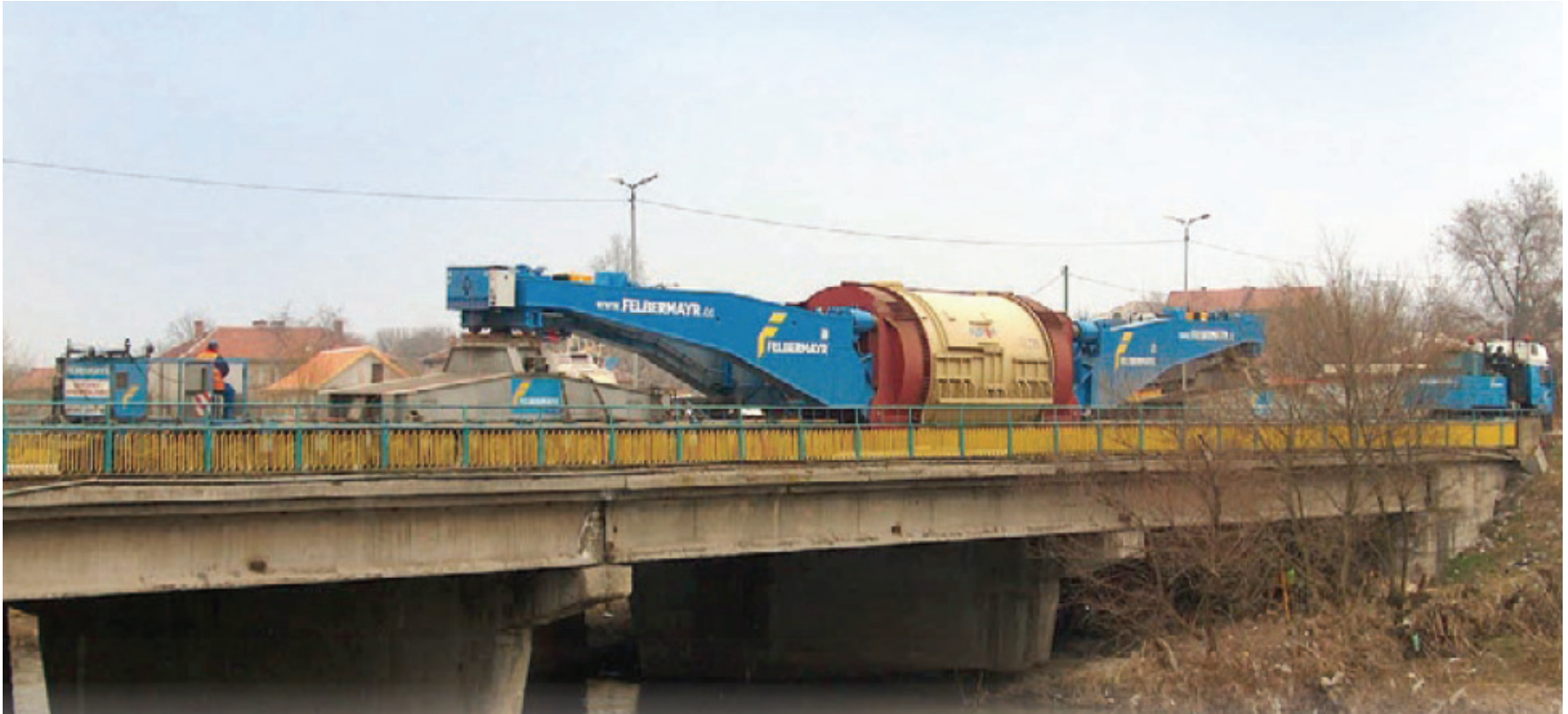
Ponte Sulzliyka in Bulgaria Applicazione di Sika CarboDur® a basse temperature
