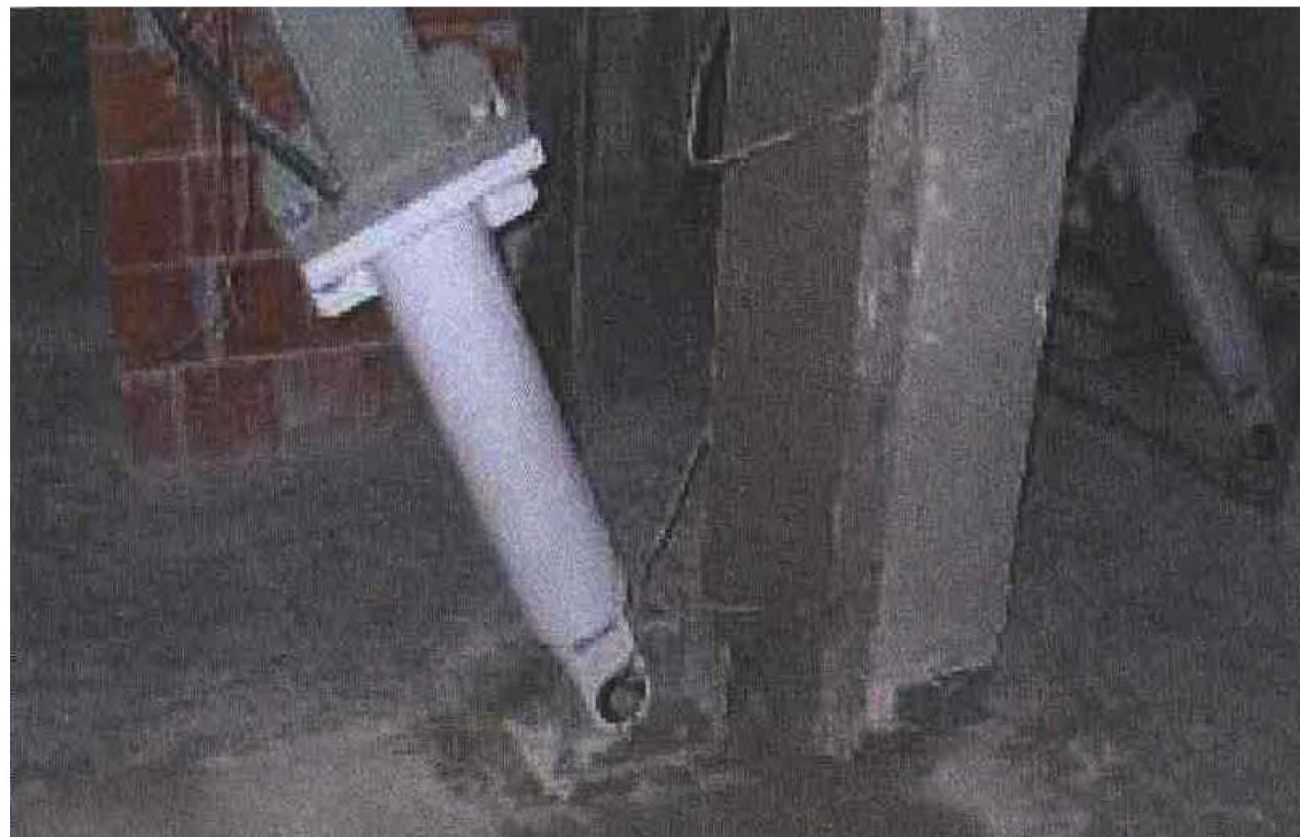
PARTICOLARE ATTACCO DISSIPATORE
