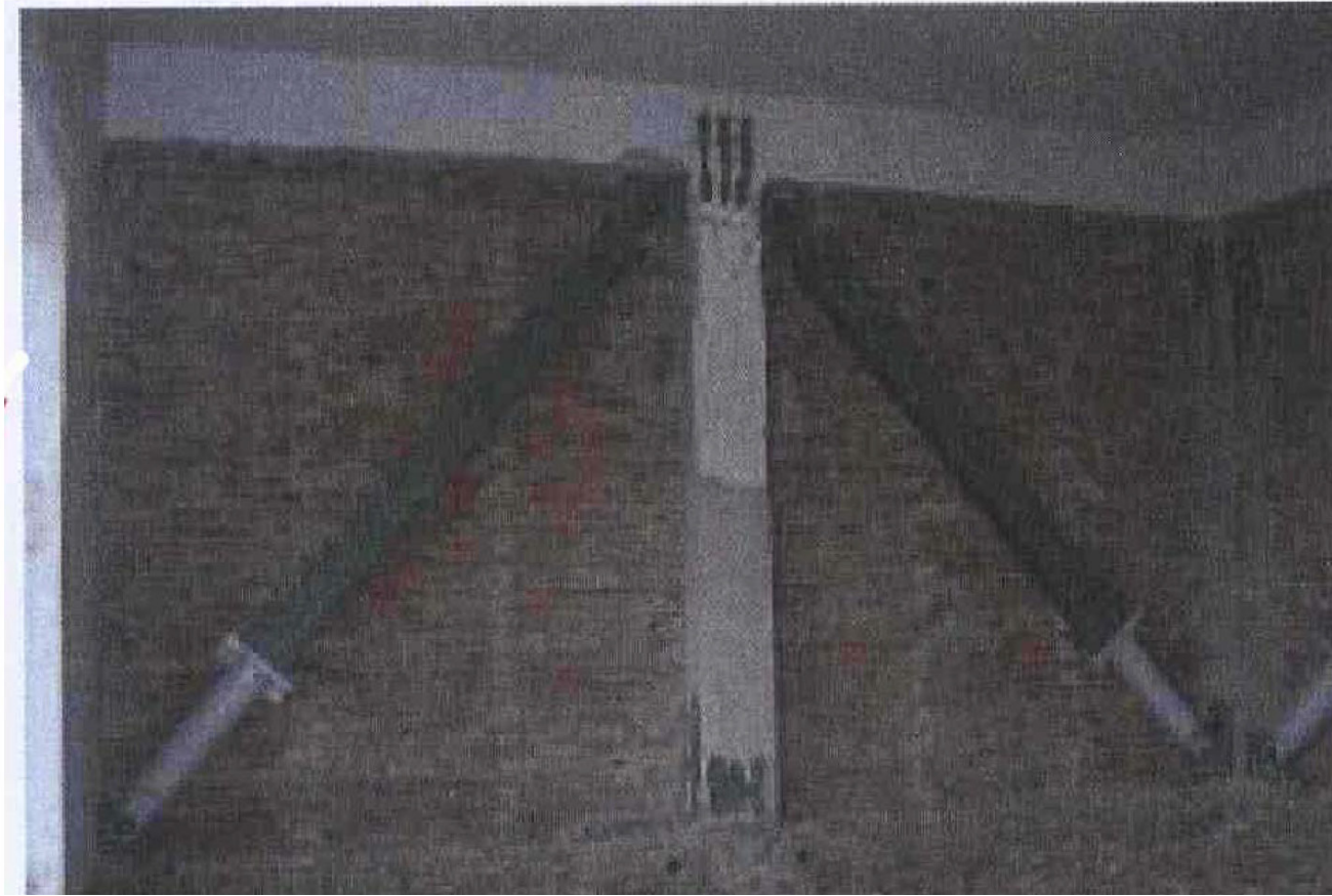
PARTICOLARE ATTACCO DISSIPATORE
