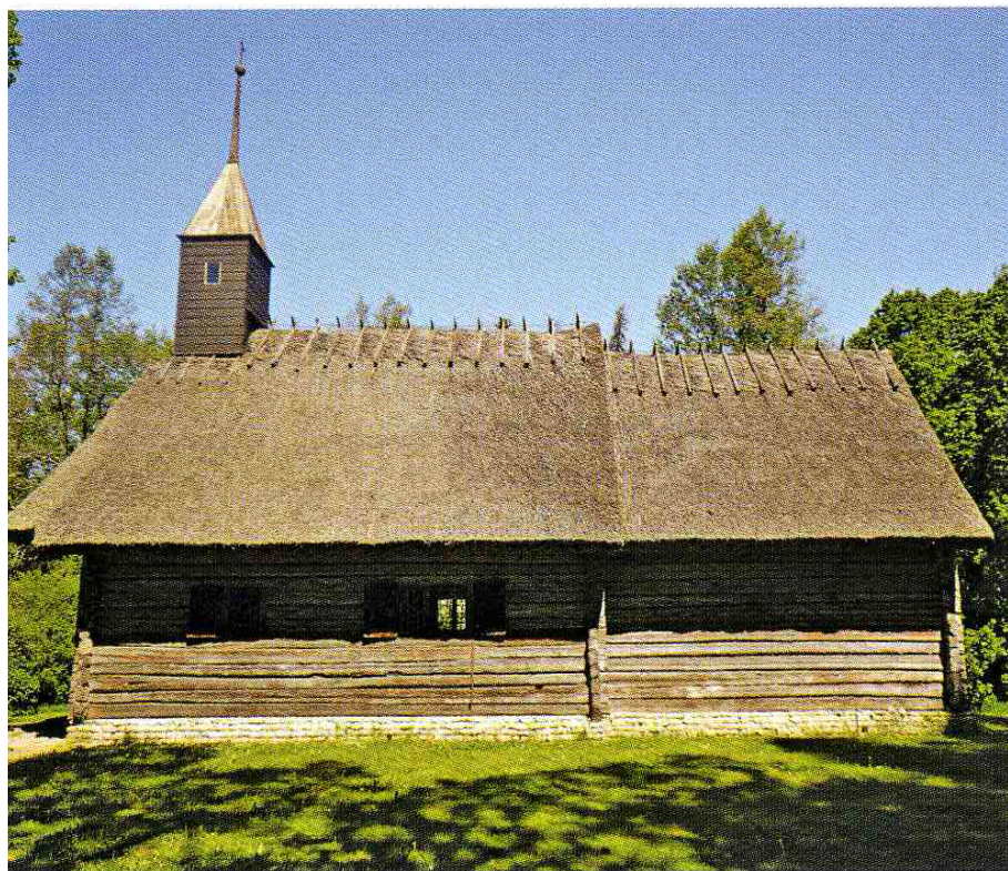
ESEMPIO DI EDIFICIO TRADIZIONALE REALIZZATO CON TECNICA BLOCKBAU
