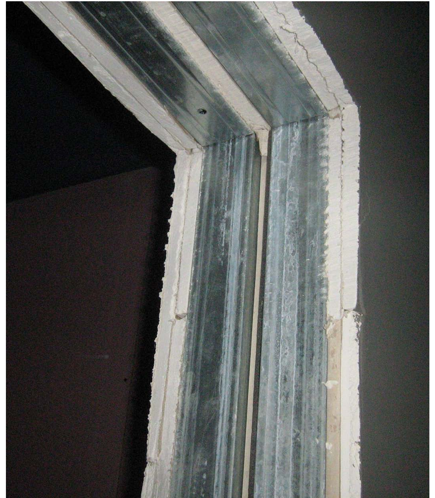
IMMAGINE PARETE INTERNA
